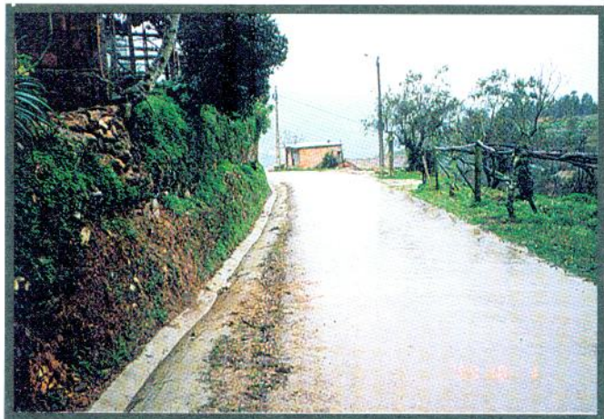
Cedência de materiais à Junta de Freguesia de Talhadas para a construção de valetas na Frágua.
