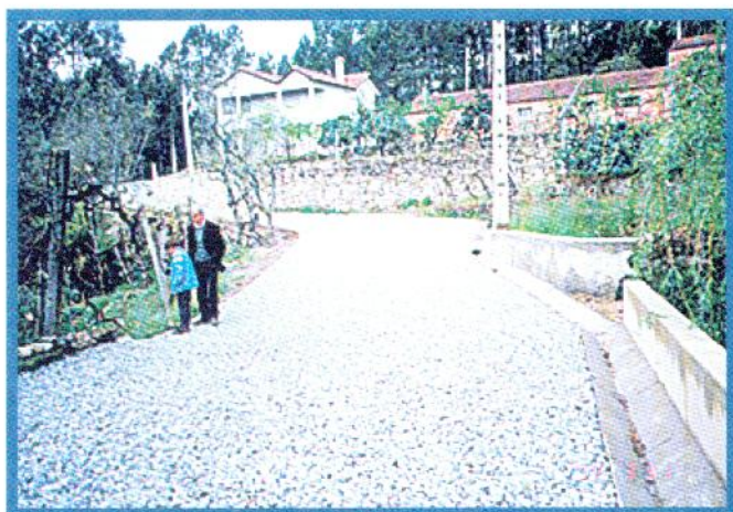
Estrada de Lourizela/Parada - pavimentação.
