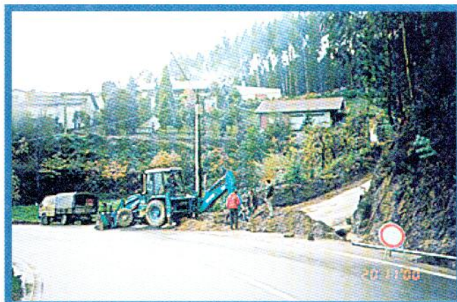
Abastecimento de água a Vila Sêca - em execução.
