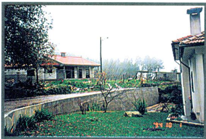
Muro de suporte à entrada em Dornelas e alargamento da mesma.
