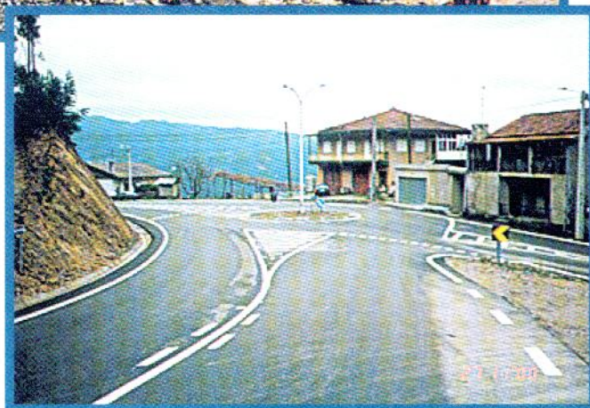
Acesso ao Campo de Jogos/Rocas - rectificação e pavimentação.
