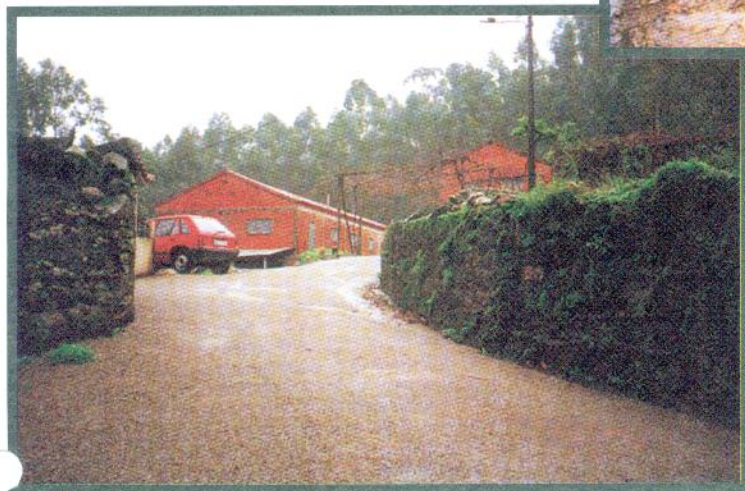
Repavimentação na Varziela - Cedrim.
