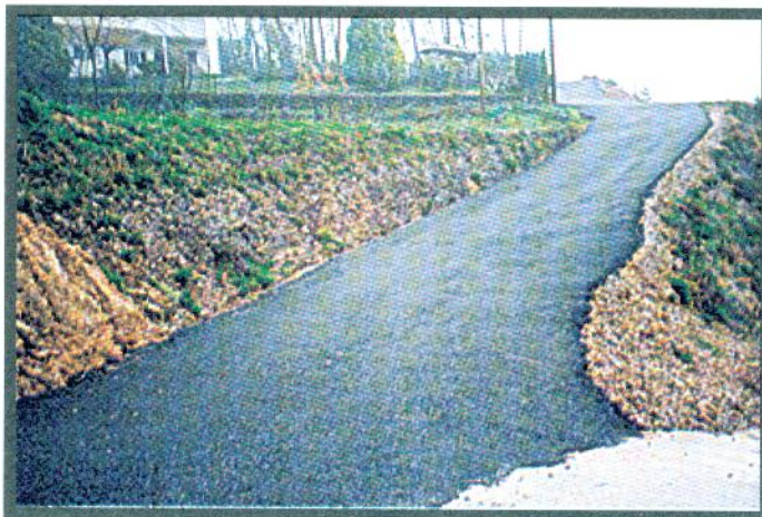
Pavimentação a frio em Dornelas.
