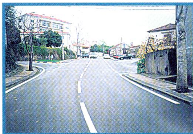
Pavimentação da rua da EN 328 ao Pombal.
