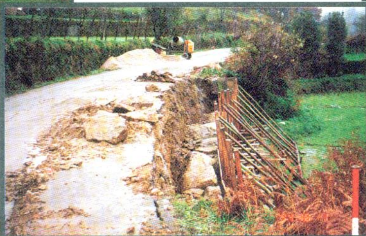
Alargamento e melhoramento do caminho florestal em Catives com aqueduto novo.
