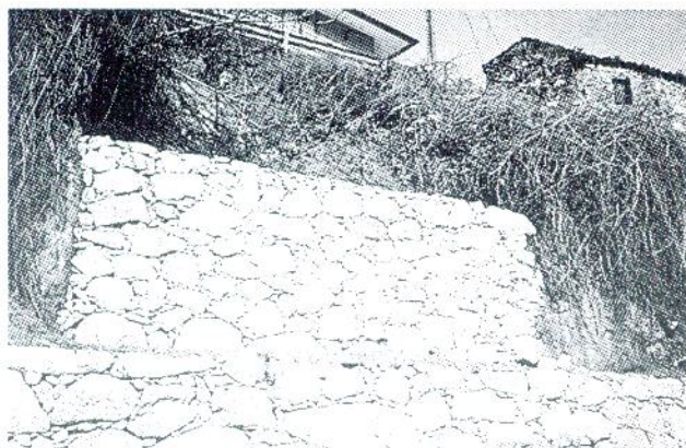
Muro complementar para suporte, na Lomba - Pessegueiro do Vouga.
