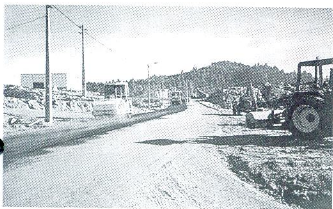
Pavimentação do acesso à Zona Industrial de Cedrim.
