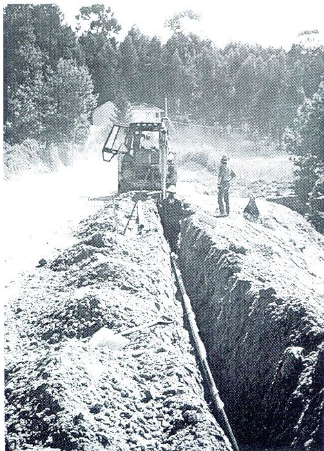
1ª Fase do abastecimento de água a Dornelas (Presas e Castelões) - E.N. 328.
