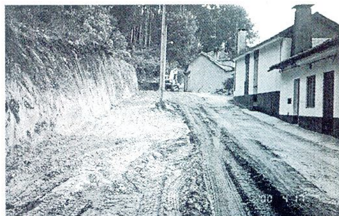
Rectificação e pavimentação do Caminho da Arrompida - Paradelas.
