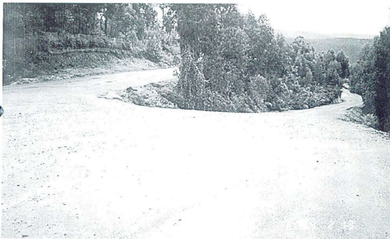
Melhoramento dos acessos nas traseiras da Escola Secundária e E.B. 2, 3.
