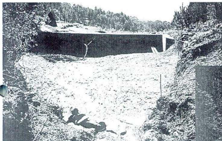
Preparação para impermeabilização da represa do Vale do Grou em Dornelas. Prevenção de fogos florestais.
