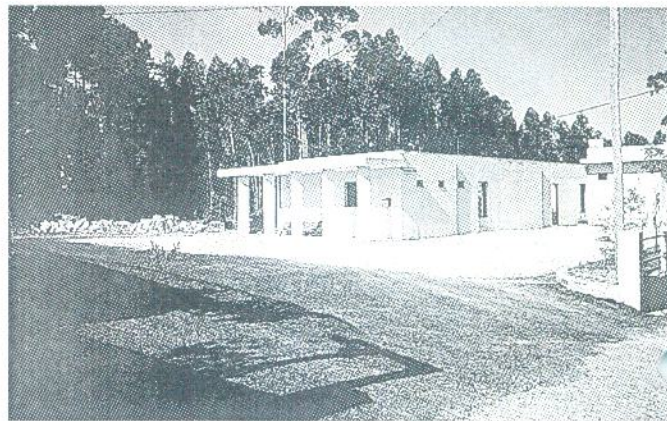
Alcatroamento a frio em Dornelas - Largo da Junta de Freguesia.
