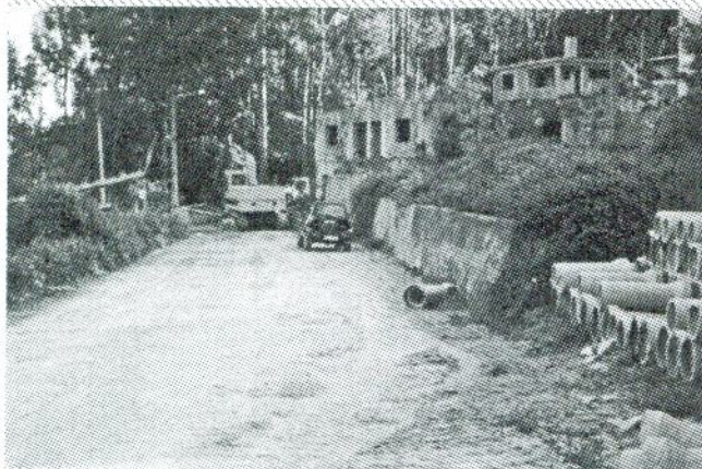
Arruamento da E.N. 328 à Capela da Sr a de Fátima. Colocação de rede de esgotos e águas pluviais.
