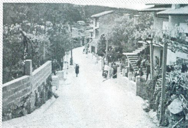
Caminho do Cascalhal (Carrazedo). Alargamento e pavimentação.
