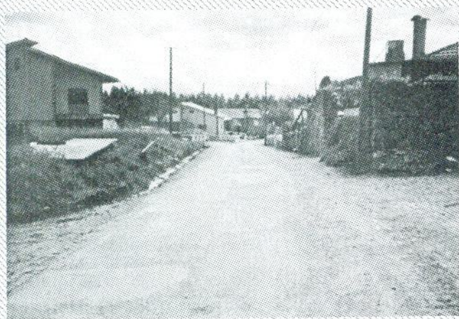
Estrada da Silveira / Arcas - Limpeza e escarificação para repavimentação.
