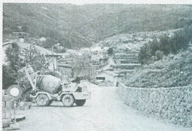
Estrada de Rocas à Leira-Vougas. Construção de muros de suporte e colocação de tout-venant.
