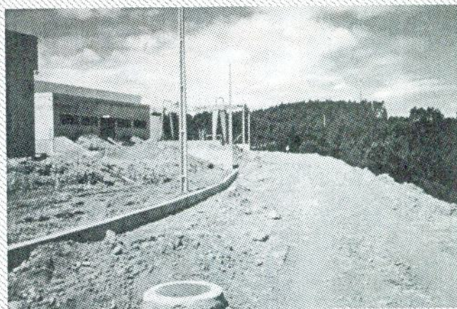
Zona Industrial de Talhadas. Conclusão dos arruamentos.
