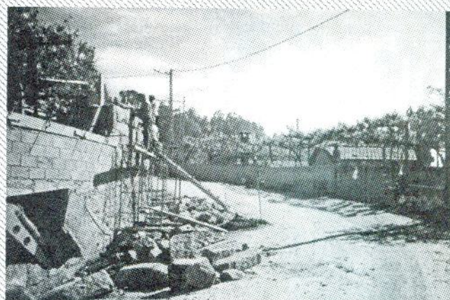
E.N. 328-1. Demolição e reconstrução de casa.
