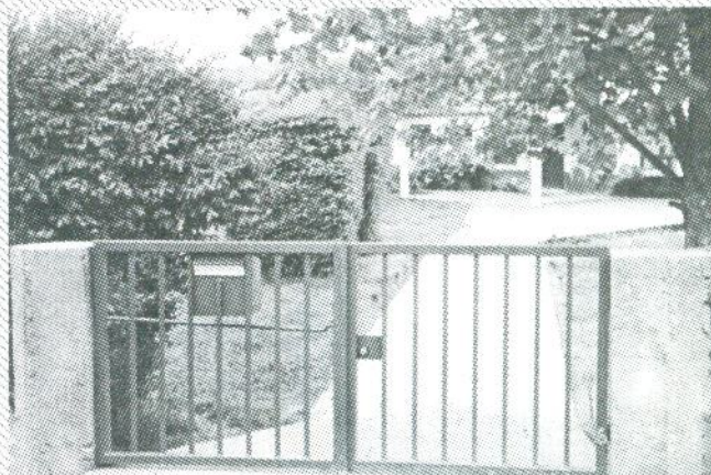
V edação e colocação de portão no Jardim de Infância da Senhorinha - Sever do Vouga.
