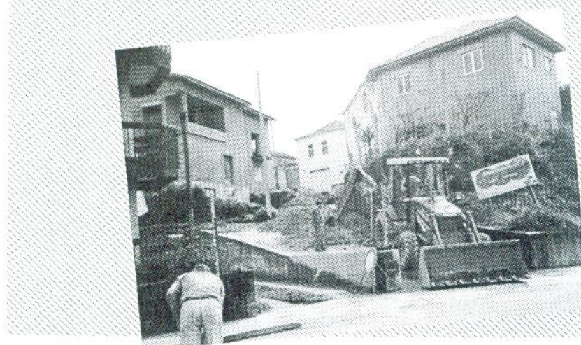
Ampliação da rede de esgotos na Vila.
