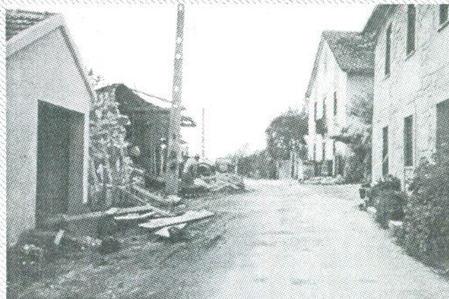
E.M. 569 Couto de Esteves / Vilarinho - 1ª fase. Demolição de casa - Trabalhos finais.
