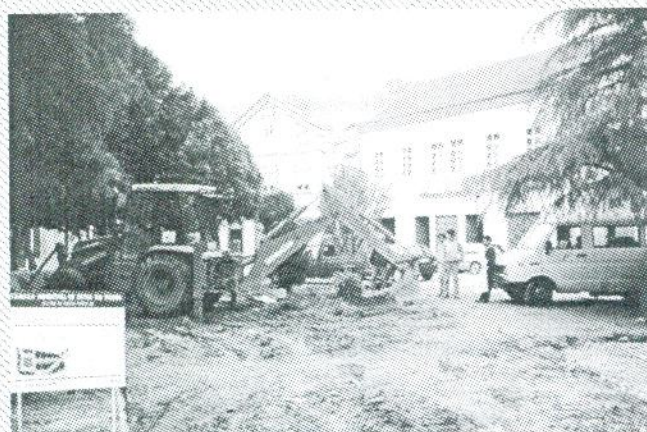
Jardim do Lago (início dos trabalhos).
