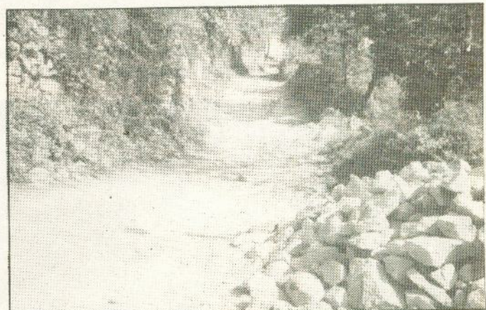
Catives — Calçetamento avança em bom ritmo. Aspecto intransitável do caminho que vai ser reparado (ao lado vê-se já um monte de pedra para continuação das obras).
