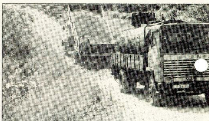
Vilarinho (Talhadas) — Pavimentação.
