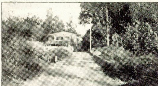
Espinheiro — Arruamento de ligação à E.N. 328 feito por administração directa da Câmara.
