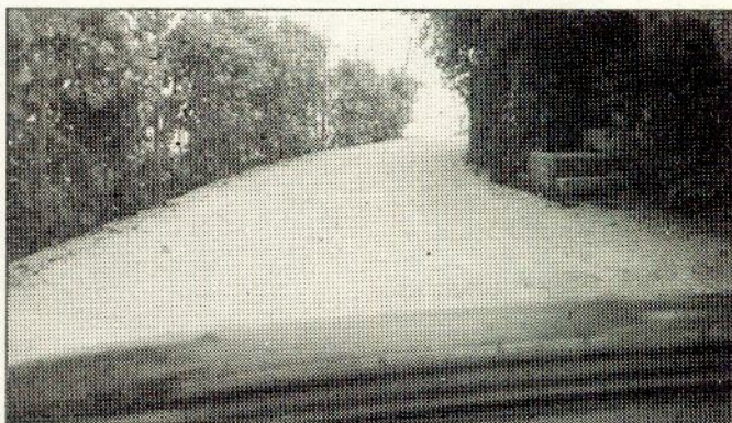
Cabeço da Forca (Pessegueiro) — repavimentação recentemente efectuada.
