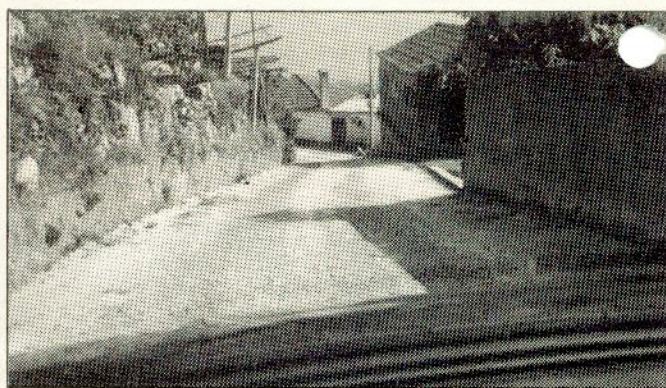
Nespereira de Cima — Rua inferior (pavimentação). Rocas.
