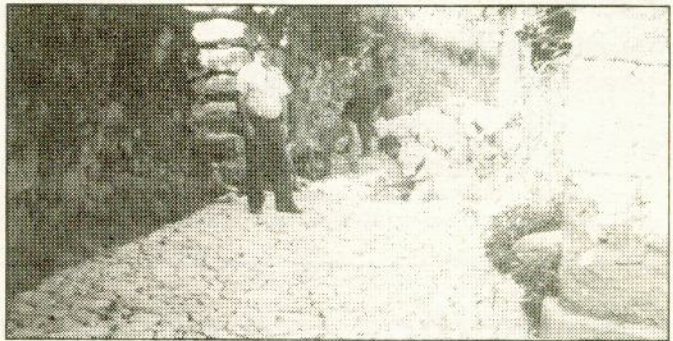
Início dos trabalhos em Catives. Este rústico e típico lugar do concelho manterá as suas características já que a sua ruela inferior, tal como as moradias, será em granito (calçada à portuguesa).
