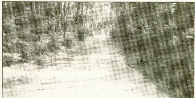
Ligação das Bouças ao Cruzeiro e Quintã (Silva Escura). Uma obra feita no ano passado.
