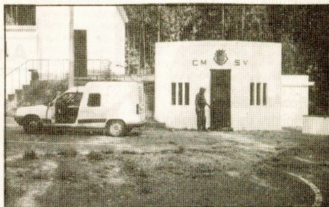
Arranjo e pintura dos depósitos de água no Sossego.
