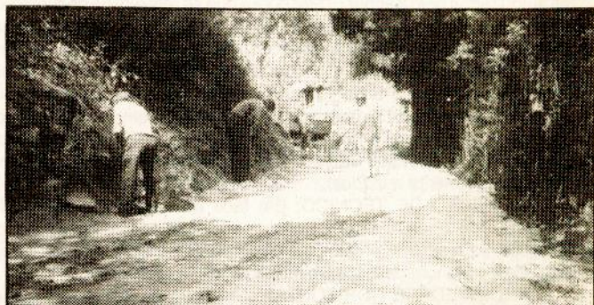
Preparação do piso para pavimentação na Ermida
