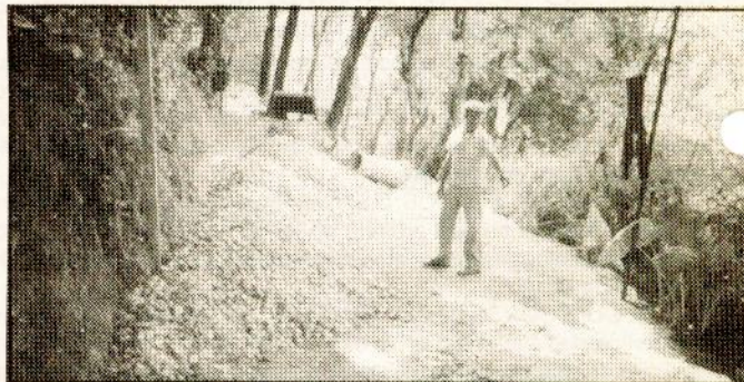
Ermida — Início dos trabalhos de construção de arruamento.
