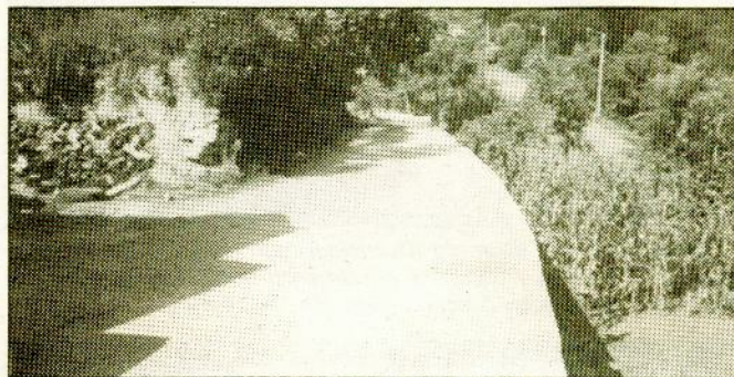
Arruamento da Acimada (Couto). Uma obra do início deste mandato. Brevemente será cortada e demolir parte de uma casa para conclusão dos trabalhos.
