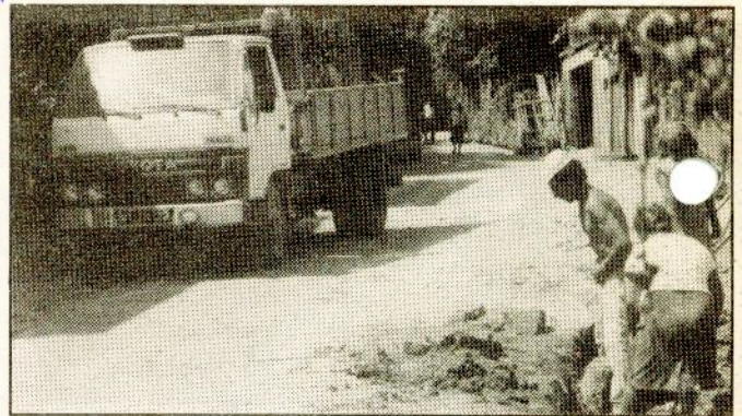
Trabalhos de alargamento e repavimentação de ruas em Nogueira — Pessegueiro
