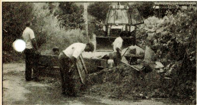
Construção de aqueduto para drenagem de águas pluviais no Fojo.
