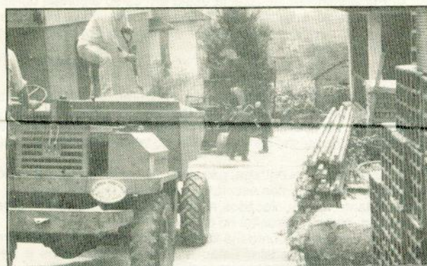
Pavimentação de novo arruamento em Fontelos — Cedrim
