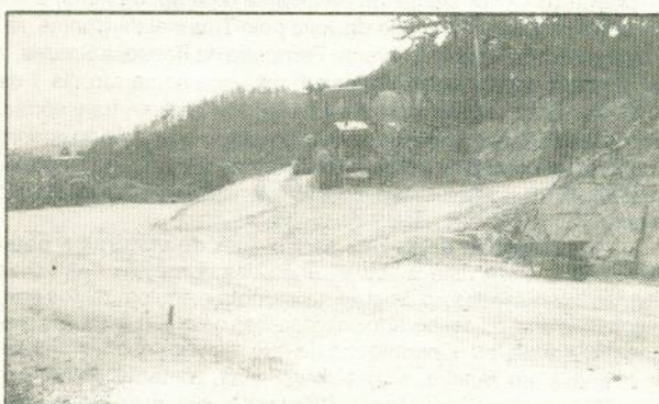
Início dos trabalhos de Pavimentação da ligação da Vide a Destriz (Câmara/FEDER).
