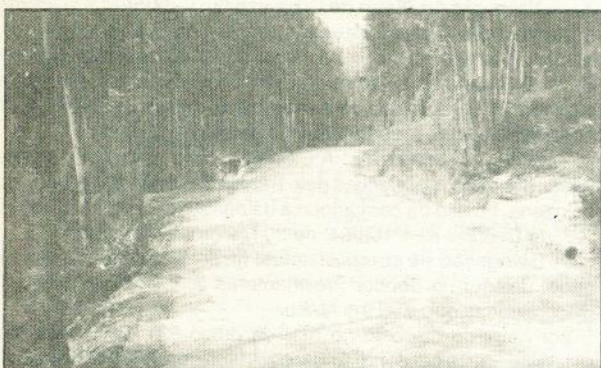
Pavimentação do Seixo à E.N. 333.
