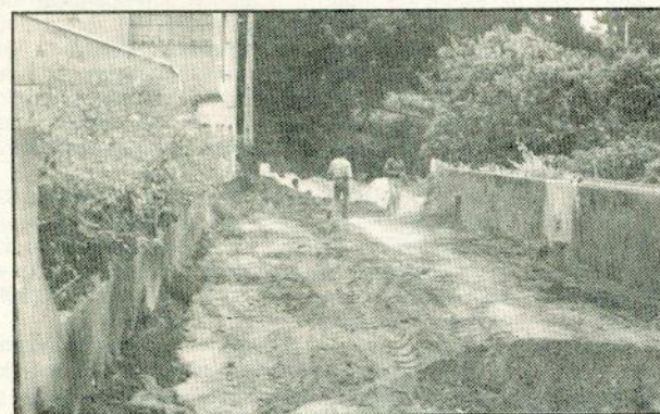
Início dos trabalhos de colocação de rede de esgotos, águas pluviais, passeios e pavimentação do arruamento da Torre à Cruz do Peso — Senhorinha
