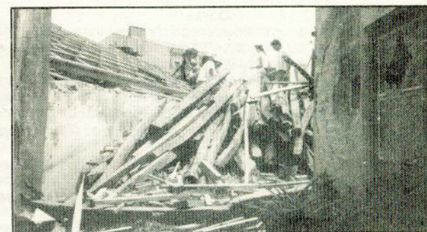
Remodelação do telhado na Casa da Cultura
