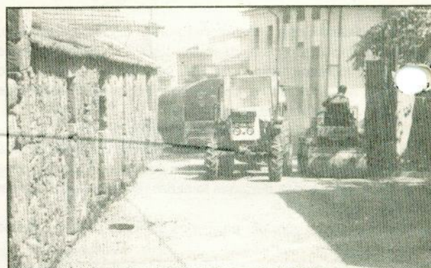
Reparação geral do arruamento central de Sanfins — Rocas
