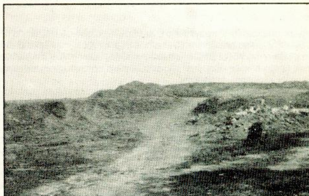
Zona Industrial de Talhadas (Início dos Trabalhos).
