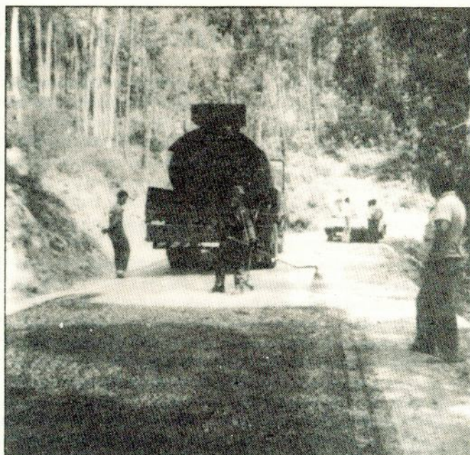
Arranjo e pavimentação da ligação do Seixo à E.N. 333
