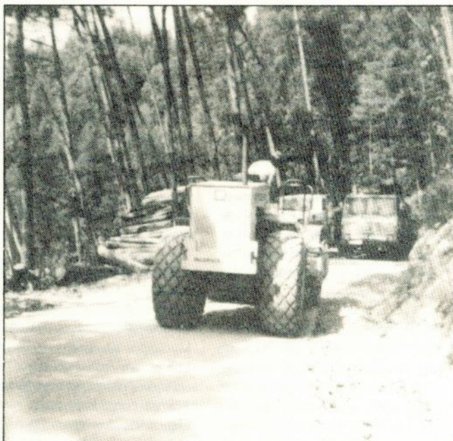
Trabalhos no Seixo.
