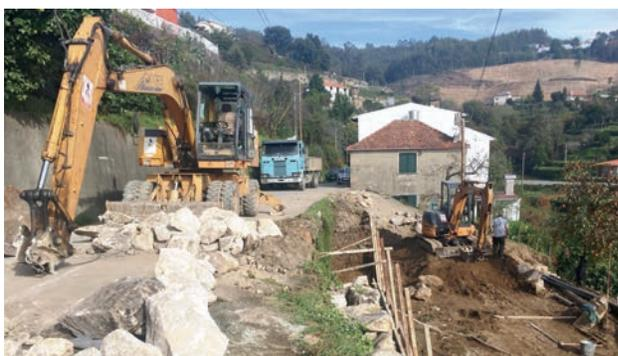
***Construção de muro de suporte no centro de Rocas do Vouga***
