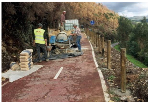
*Colocação de guardas de madeira de proteção na pista ciclável, em consequência dos incêndios do Verão – Pessegueiro do Vouga*
