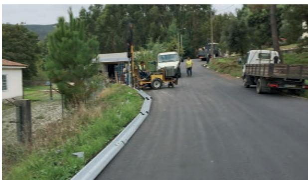
*Estrada de Sanfins – Aplicação de guardas metálicas de proteção – Rocas do Vouga*
