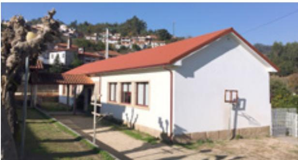
Esta intervenção deve-se, essencialmente, à entrada de água no edifício (infantário), tendo em conta que muitas telhas encontravam-se partidas e degradadas. Para salvaguardar a estabilidade da estrutura e eliminar a entrada de água, substituiu-se toda a cobertura por chapa sanduiche a imitar telha. Valor de adjudicação: 11.300,00 euros.
